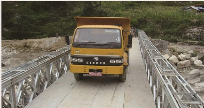
尼泊尔321型30米双排单层加强型单车道镀锌贝雷桥
